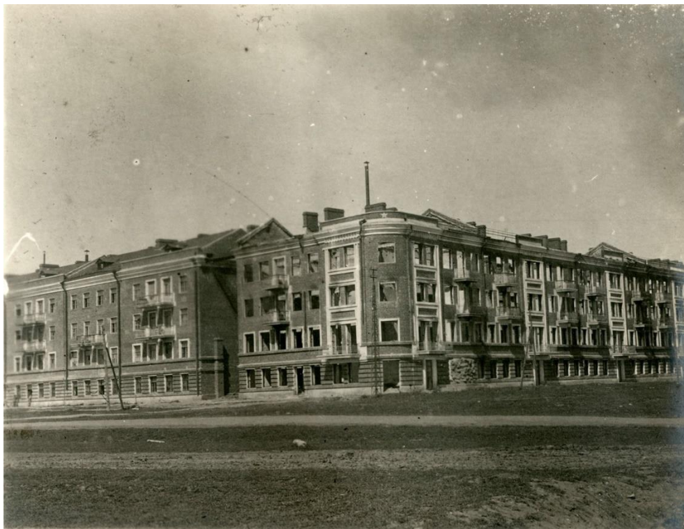
Разрушенное здание на углу Ростовского шоссе и Зиповской. Краснодар, 1943 год.
