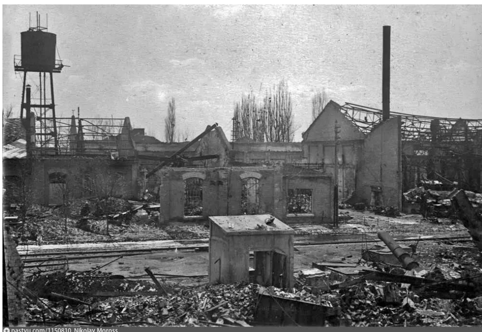
Разрушенный завод имени Седина
