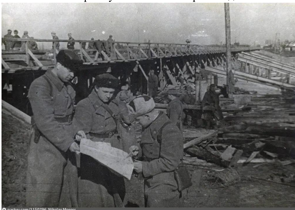
Восстановление моста через Кубань 1943 со стороны Адыгеи
